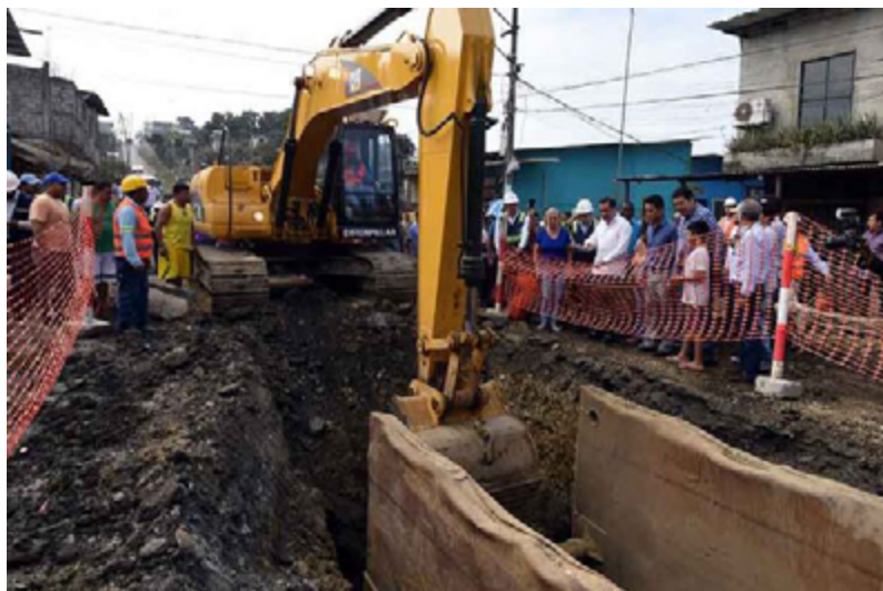
Ilustración 59. Trabajos de alcantarillado en la comunidad Flor de Bastión – Guayaquil Fuente: https://eloficial.ec/inician-trabajos-de-alcantarillado-sanitario-en-flor-de-bastion/
