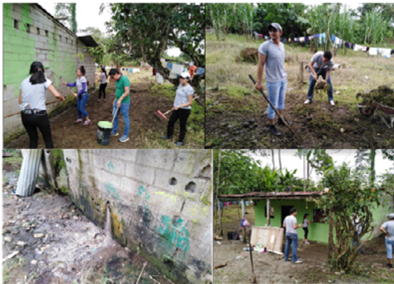
Ilustración 13. Condiciones exteriores de la vivienda
