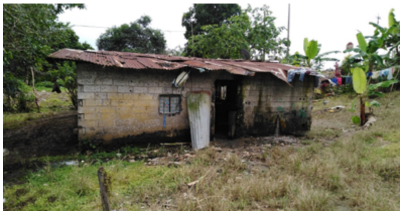
Ilustración 19. Condiciones de la vivienda antes de la intervención del Proyecto Social
