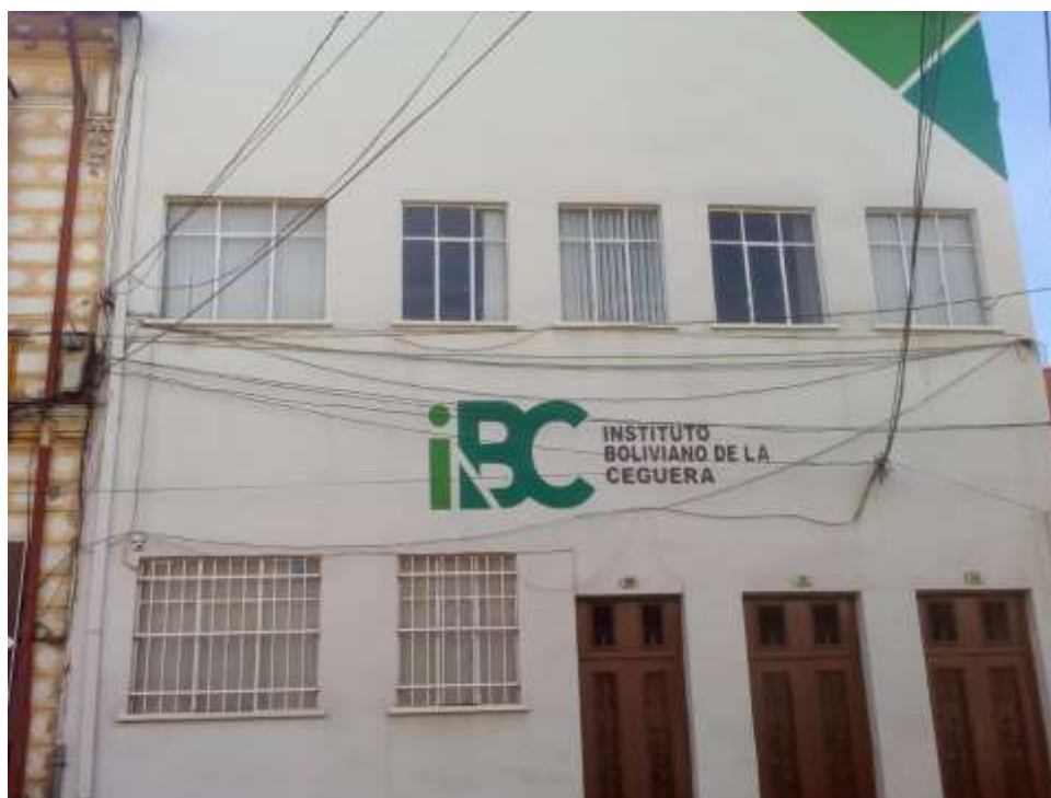
Fotografía: edificio del Instituto Boliviano de la Ceguera en la ciudad de La Paz, Bolivia.
