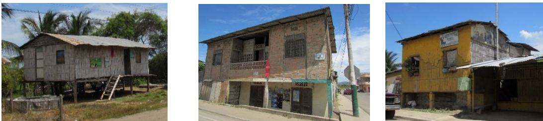
Figura 10: Vivienda popular tradicional en Portoviejo: levantada sobre pilotes, los tres cuerpos y el “enquinche” (Elaboración propia)
